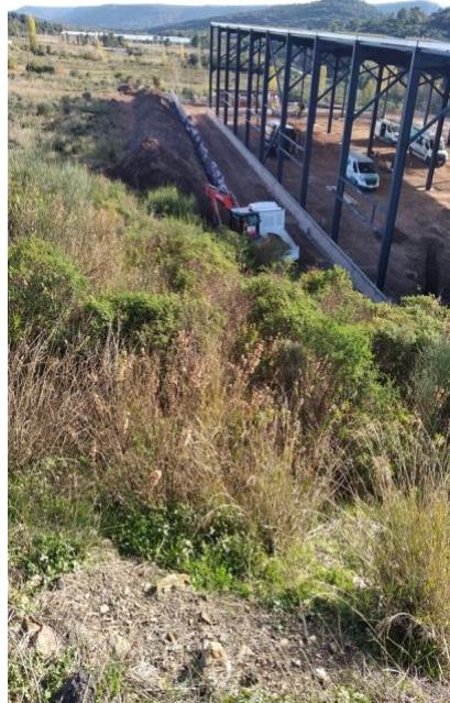
Chantier HB Bat, le 30/11/2023
